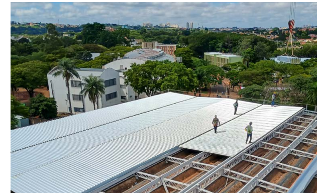
Cobertura do prédio da biblioteca central
