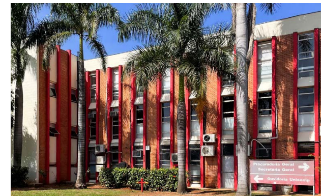
Recuperação da fachada do prédio modulado - prefeitura
