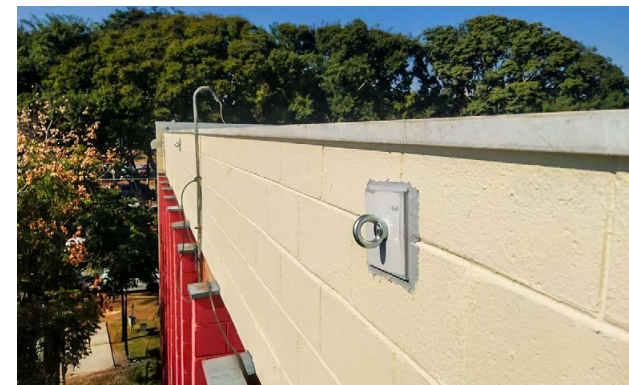
Instalação de ponto de ancoragem no prédio modulado
