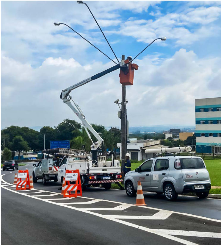
Instalação de conjunto de iluminação
