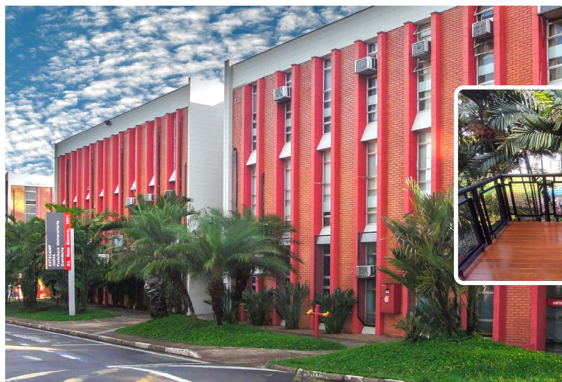
Recuperação da fachada do prédio modulado (prefeitura)
