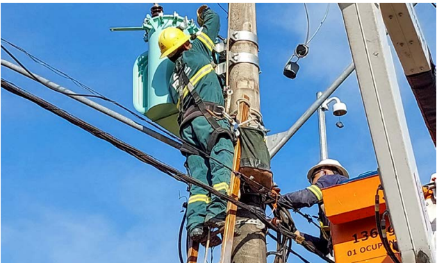
Instalação de Transformador
