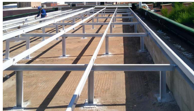
Cobertura dos prédios modulados - FCM
