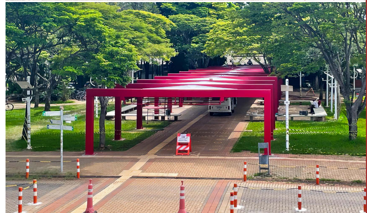
Recuperação da passarela metálica do RU/CBI
