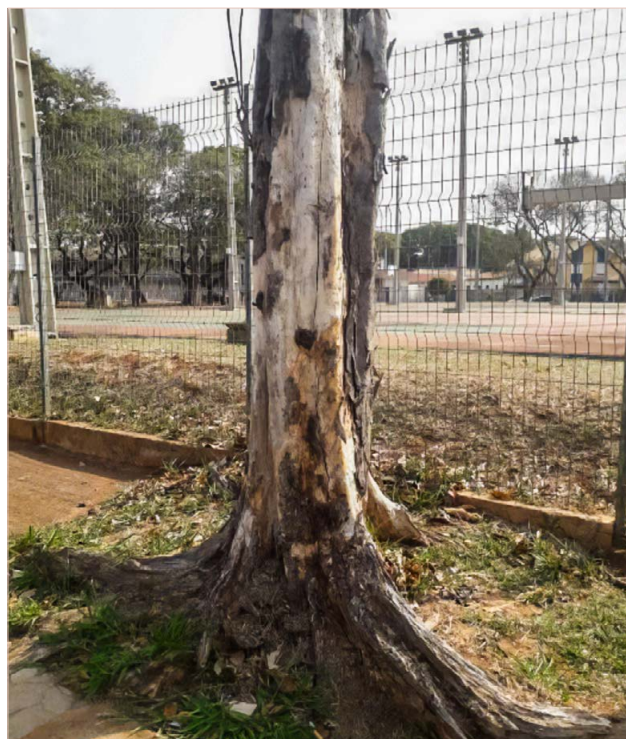
Identificação de árvore com risco de queda no estacionamento da Faculdade de Ciências Médicas: apresentação de frutificação fúngica em toda a base indicando a podridão nas raízes
