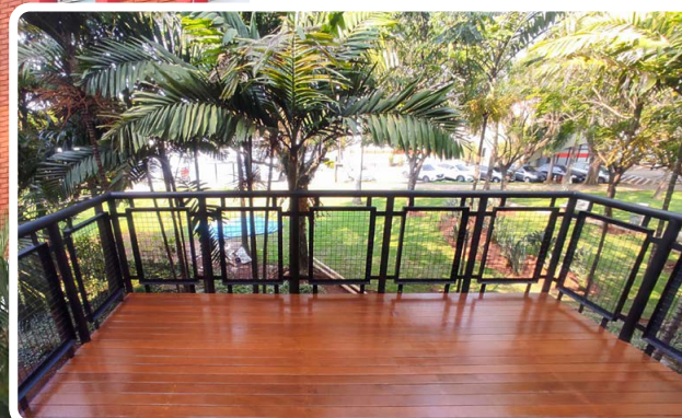
Instalação do deck na copa da prefeitura
