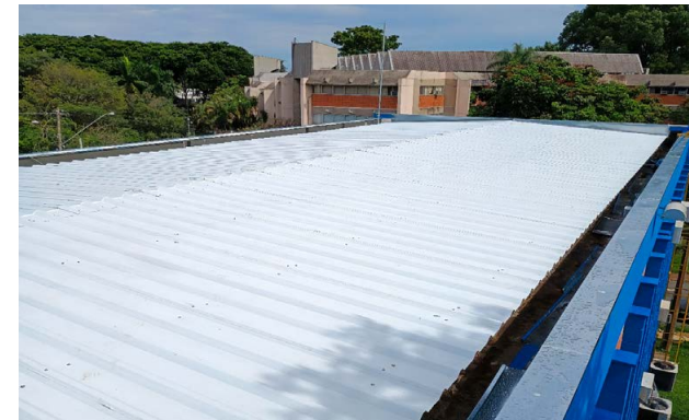
Cobertura do prédio modulado – IFGW
