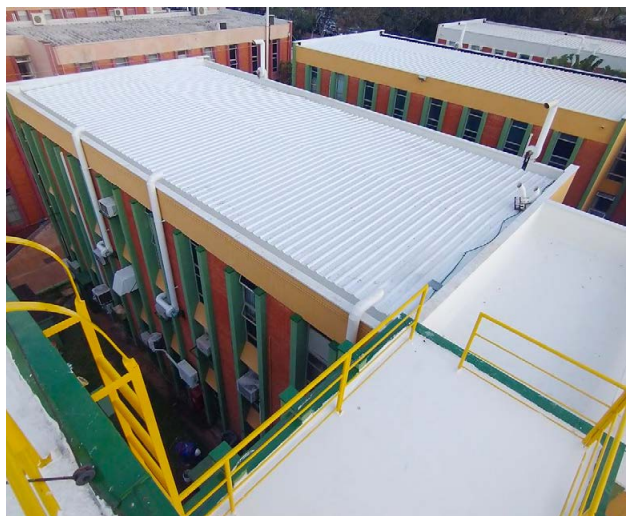
Telhados finalizados - FCM
