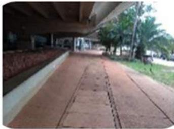
BCCL 10 - Passeio com placas de concreto, sem linha guia ou rota direcional
