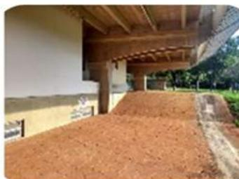
BCCL 17 - Rampa existente, com inclinação maior que 8,33% sem corrimão.
