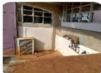
BCCL 18 - Rampa existente, com inclinação maior que 8,33% sem corrimão, se o
